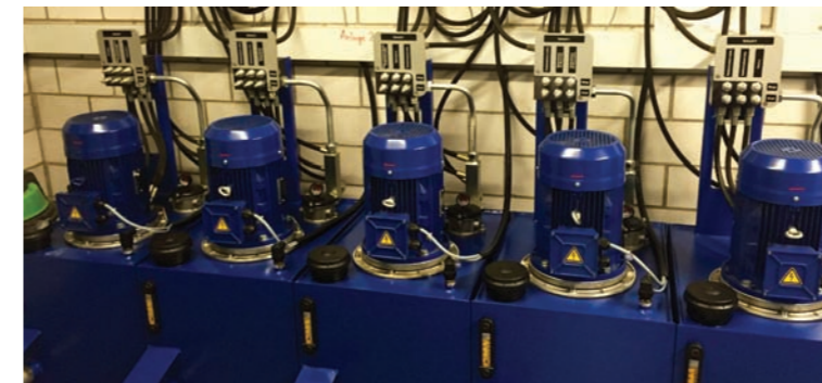
Fünf Hydraulikkompressoren pro Waschstrasse
