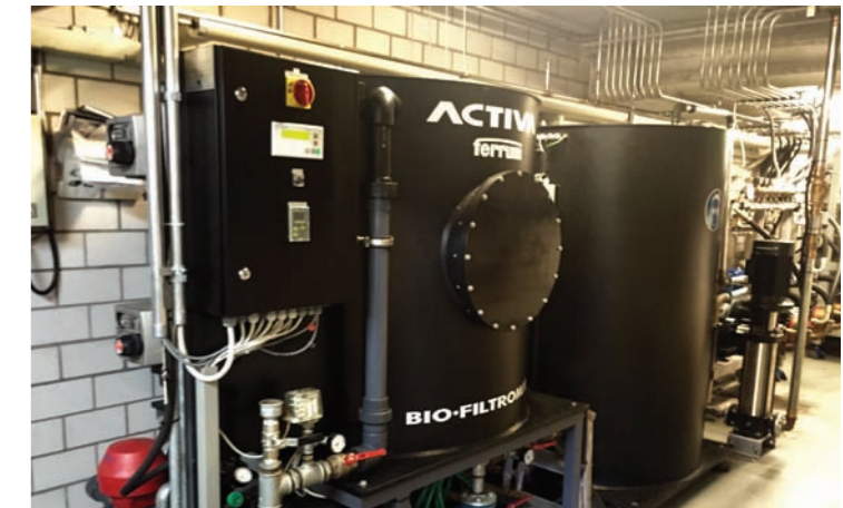
Bio-Wasserfilteranlage
