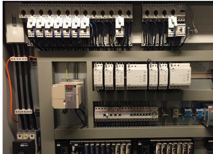
Computergesteuerter Schaltschrank
