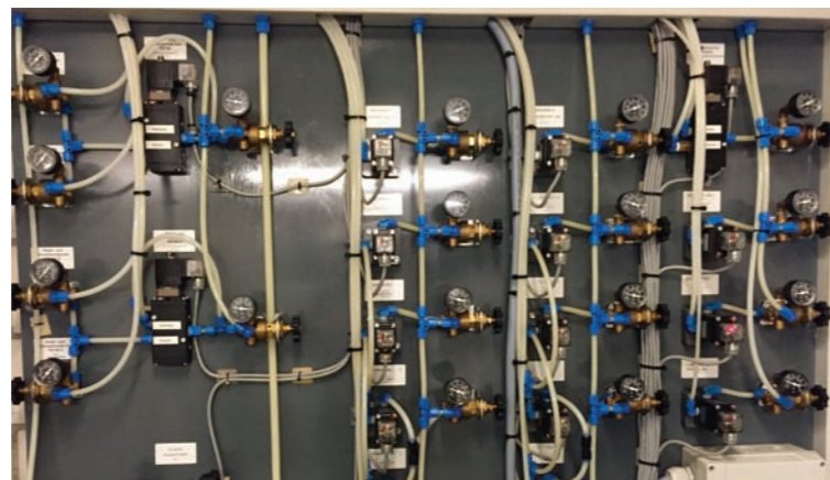
Das pneumatische Haupttableau für alle Aussteuerungen
