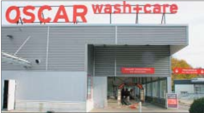
Neben dem Eingang in die Vorwaschhalle befindet sich die Einfahrt zu den Selbstbedienungswaschboxen.
